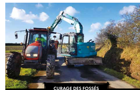
CURAGE DES FOSSÉS
